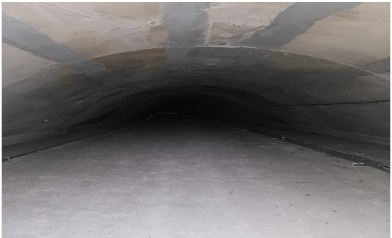
NATM구간 천단부 S54 상태양호
