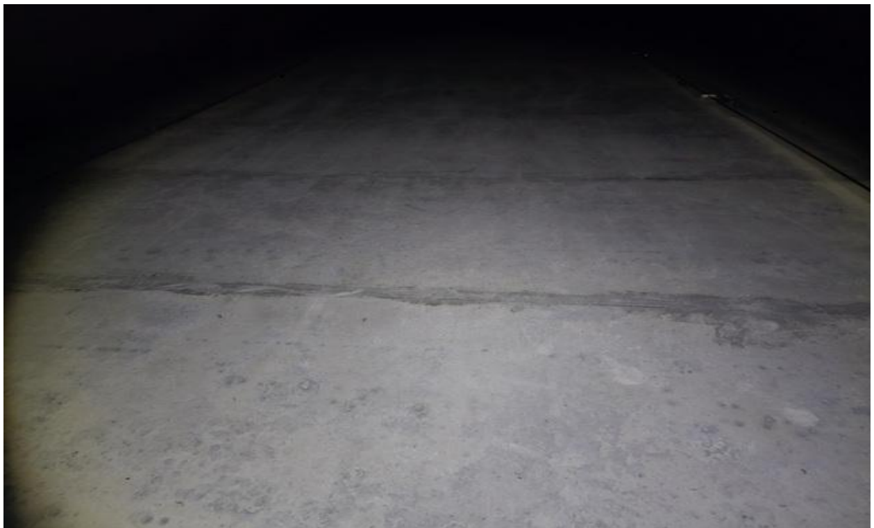
풍도슬래브 상면 S50 상태양호
