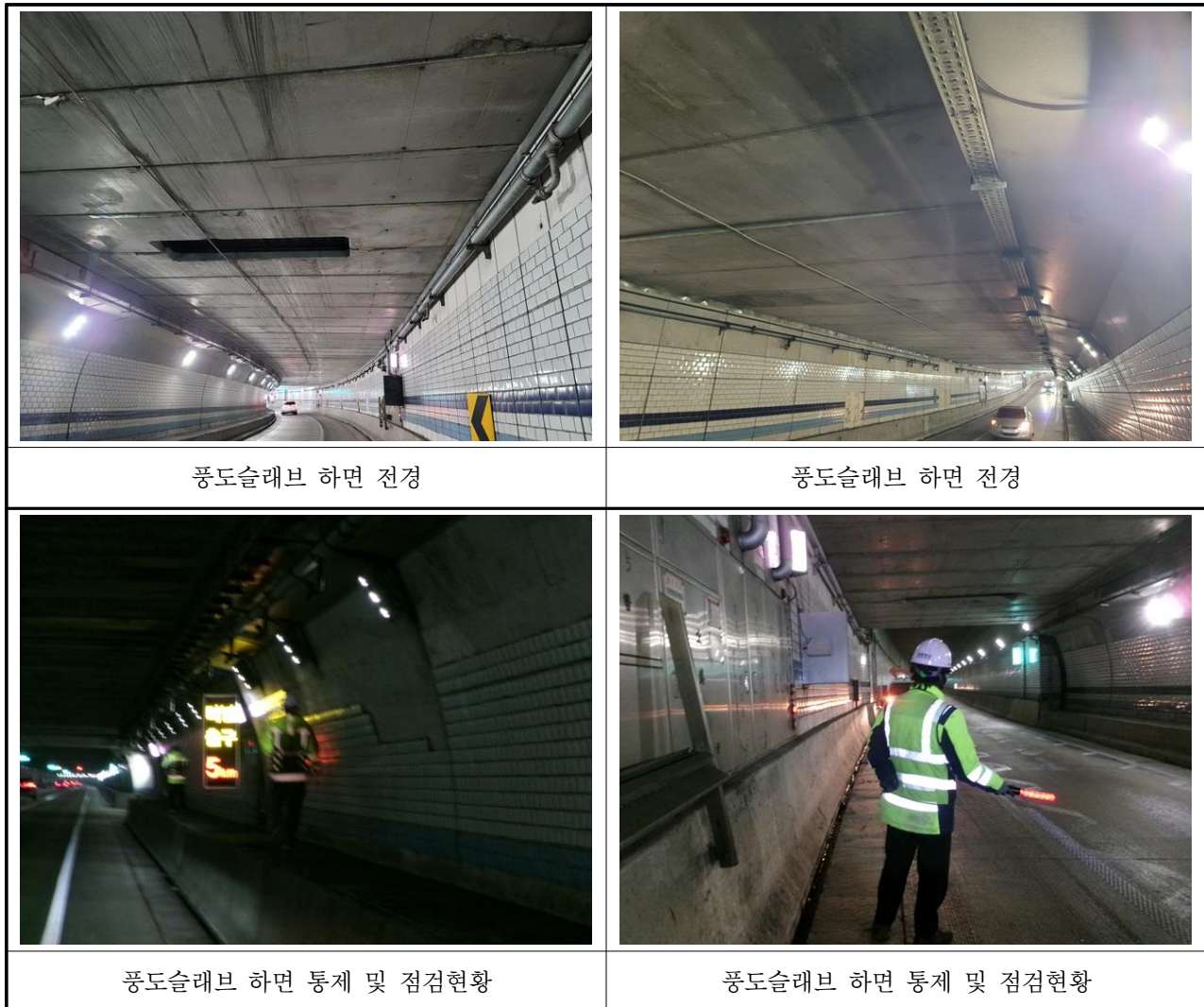
【사진 3.3.5】 풍도슬래브 하면 전경
