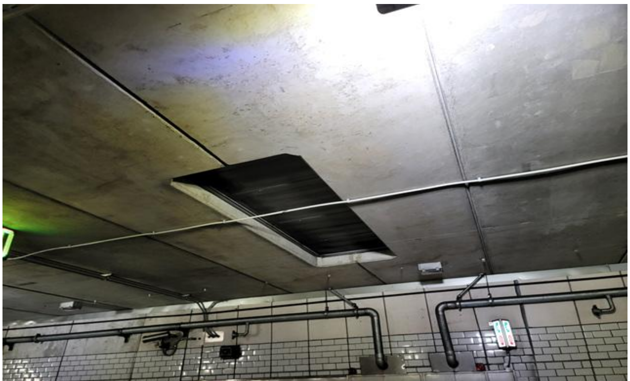
풍도슬래브 하면 S51 상태양호
